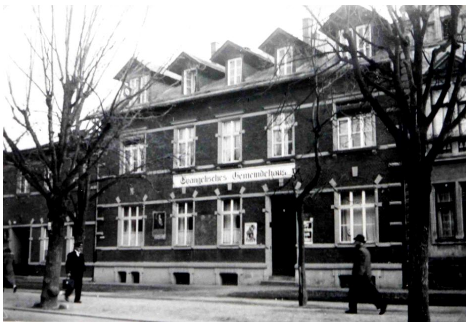
Gemeindehaus, Kaiser-Heinrich- Straße 4
